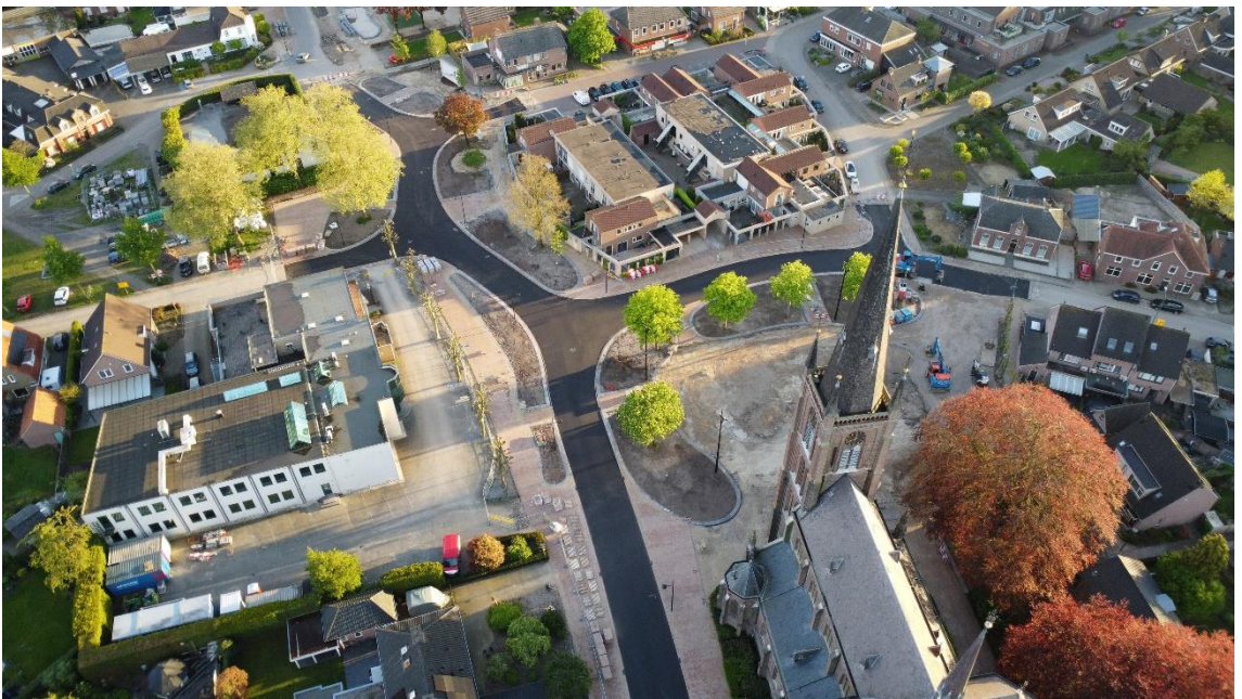
26 april 2024: Asfalt van onder- & tussenlaag tussen de basisschool - AnyTyme en de Beerseweg. Foto: 28 april 2024 Bart Janssen.
