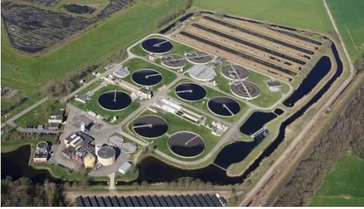
De rioolwaterzuivering Land van Cuijk in Haps
